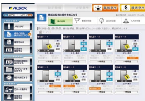
状態監視・制御画面
